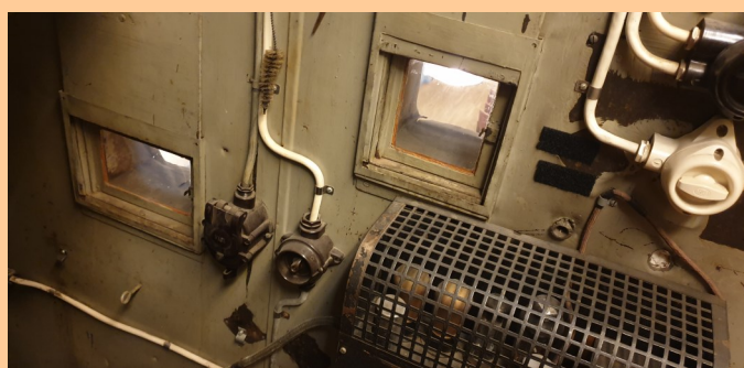
Tittar ni upp i bakre hörnet på lokalen så syns ännu två gluggar. En för projektorn, en för att maskinisten skulle kunna hålla koll på skärpan.
