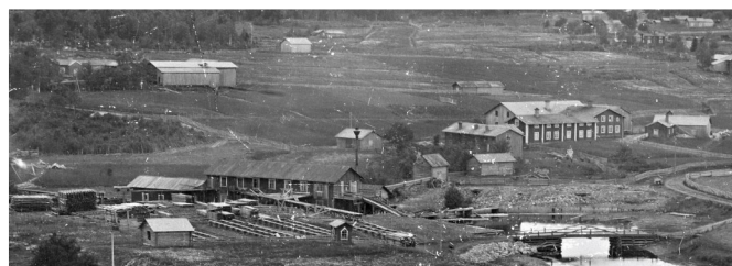
Sågen i Wij innan Glösbovägen byggdes, då vägen hade en helt annan sträckning. Ol-Lars syns till höger och Sörgårn till vänster.
