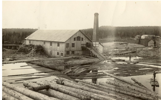
Anöänge ångsåg vid övre vägskalet till Tygsta, med Widahls i bakgrunden.
