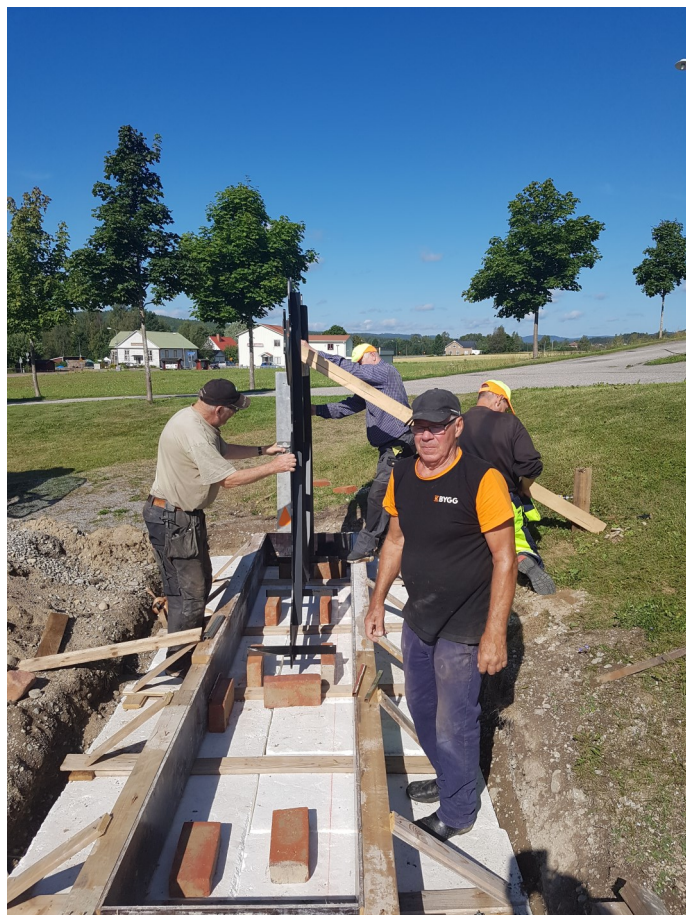
Förberedande gjutning till konstverket vid Trönö nya kyrka. I förgrunden Kent Wiklund och Bror Nyberg.
