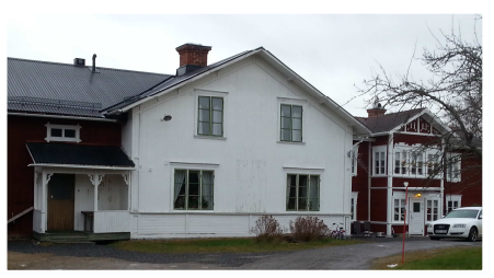
Västergårn. Det vita huset håller nu på att ställas i ordning för föreningens verksamhet. Det röda är uthyrt till boende.
